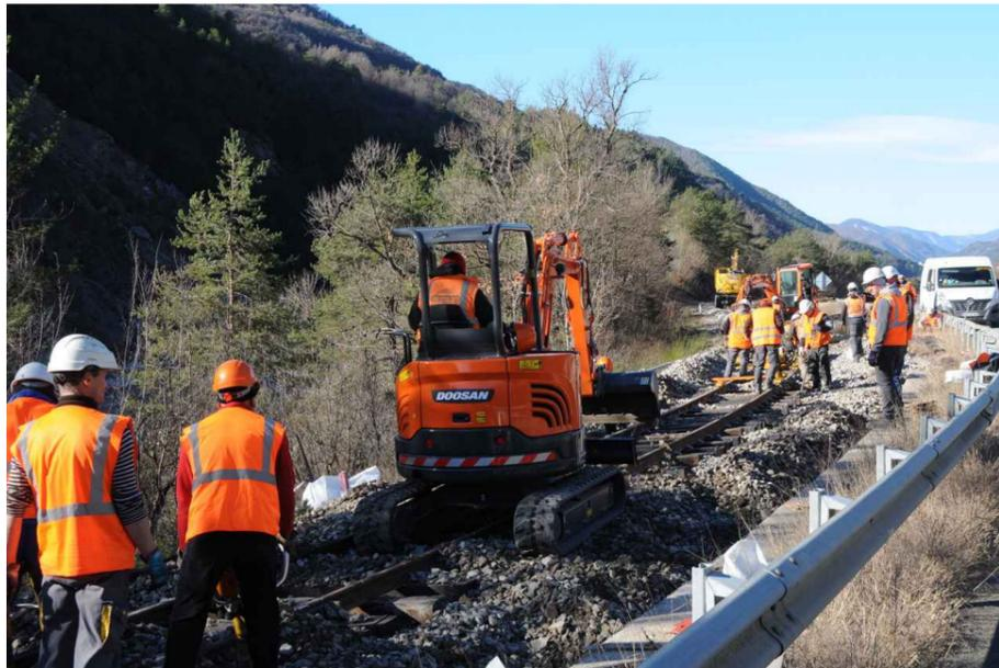
*5 des 7 zones concernées ont subi un renouvellement de rails, un remplacement partiel ou total des traverses et un apport de ballast avec bourrage, comme ici dans le secteur de La Blanquerie.*
