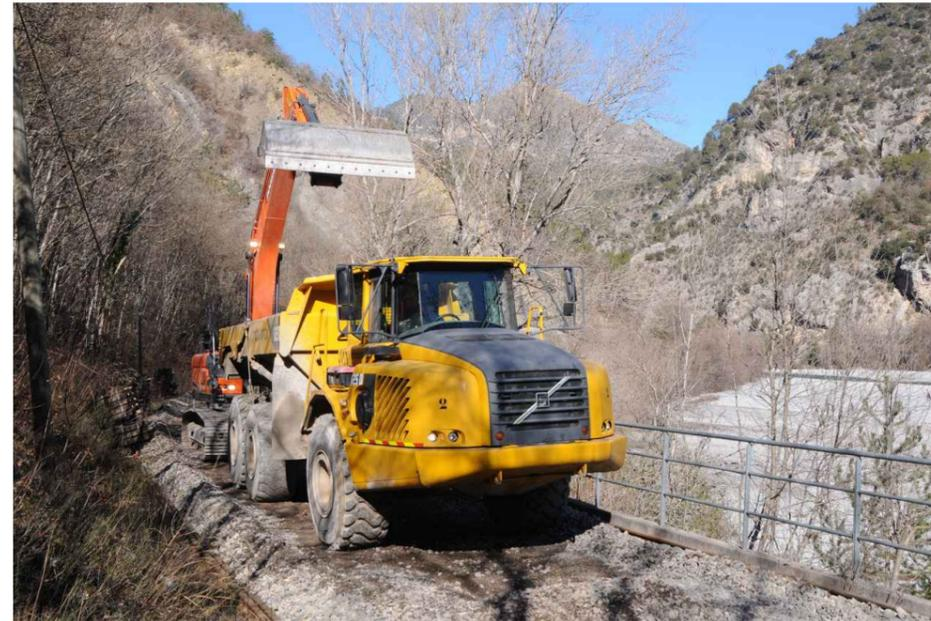
*Sur la zone de renouvellement intégral voie et ballast (RVB) de 4910 m entre le pont EDF d'Egleros et le PN de Malaussène, la plateforme a été dégarnie à la pelleuse et les déblais évacués par des engins routiers vers les deux extrémités du chantier. Une protection géotextile a ensuite été mise en place avant l'épandage du nouveau ballast.*
