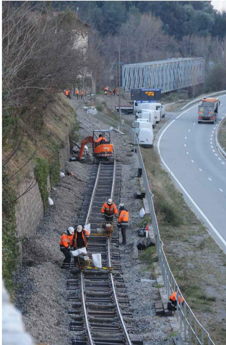
*La zone du pont de La Vésubie au Chaudan a bénéficié d'un renouvellement complet des traverses et d'un relevage de 5 cm.*
