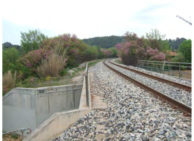
*Ci dessus, vue générale d'un pont moderne avec tablier en poutrelles enrobées, qui permet une pose de la voie sur ballast. C'est la meilleure solution du point de vue du bruit pour les riverains.*
