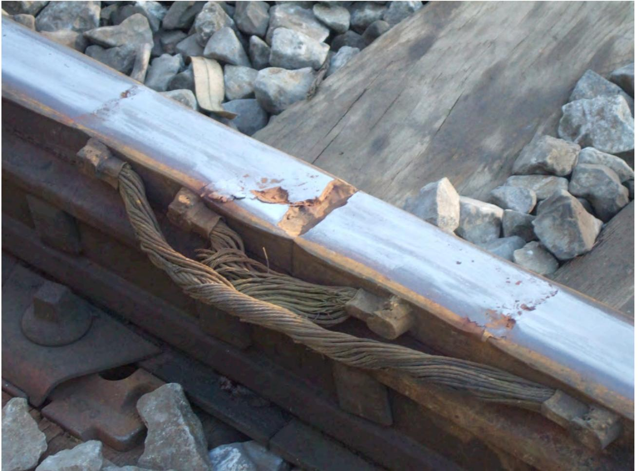
*Vous vous imaginiez avoir tout vu ! Pas mal du tout non plus ce joint : abouts de rails affaiblis avec ruptures en surface, table de roulement complètement dégradée. Nous sommes bien sur voie principale comme le prouve l'attache Nabla et la double connexion électrique.*
