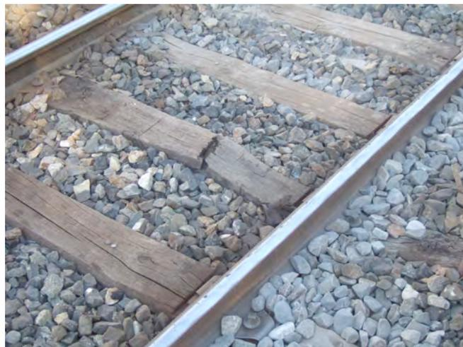
*A la gare de Marseille-Blancarde, sur la voie MV2 parcourue par des TGV à 60 km/h, une trentaine de mètres de voie présente une succession de défauts exceptionnelle. À gauche, l'attache NABLA n'a plus de tirefonds, et ne se trouve plus en face d'une traverse à moitié cassée.*
