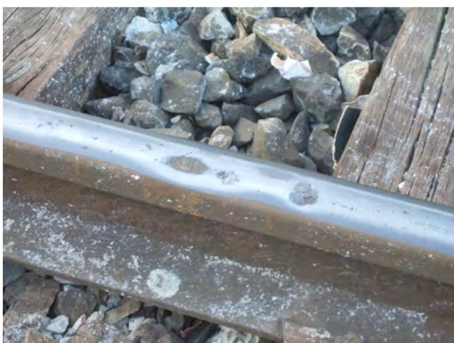
*À gauche, une soudure aluminothermique mal meulée, ce qui a créé une bosse à peine discernable, mais par rebondissement des roues, on voit apparaître à gauche et à droite du joint des amorces de patinage.*
