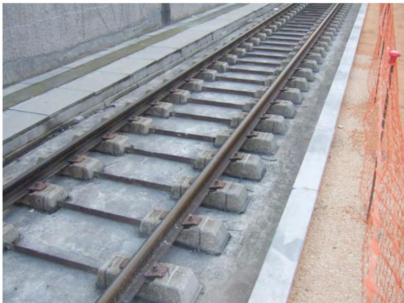
*Dans la future nouvelle gare d'Arenc, à Marseille, la voie est posée sur une dalle de béton, pour minimiser le bruit vis à vis des riverains.*
