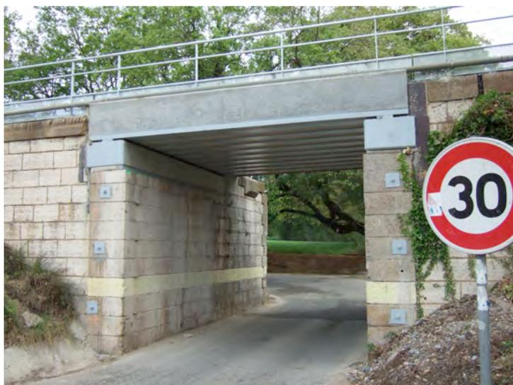
*Ci-contre, sur la même ligne, un ponceau identique a été remplacé par un ouvrage moderne avec tablier en poutrelles enrobées, et bien entendu, pose de la voie sur ballast.*
