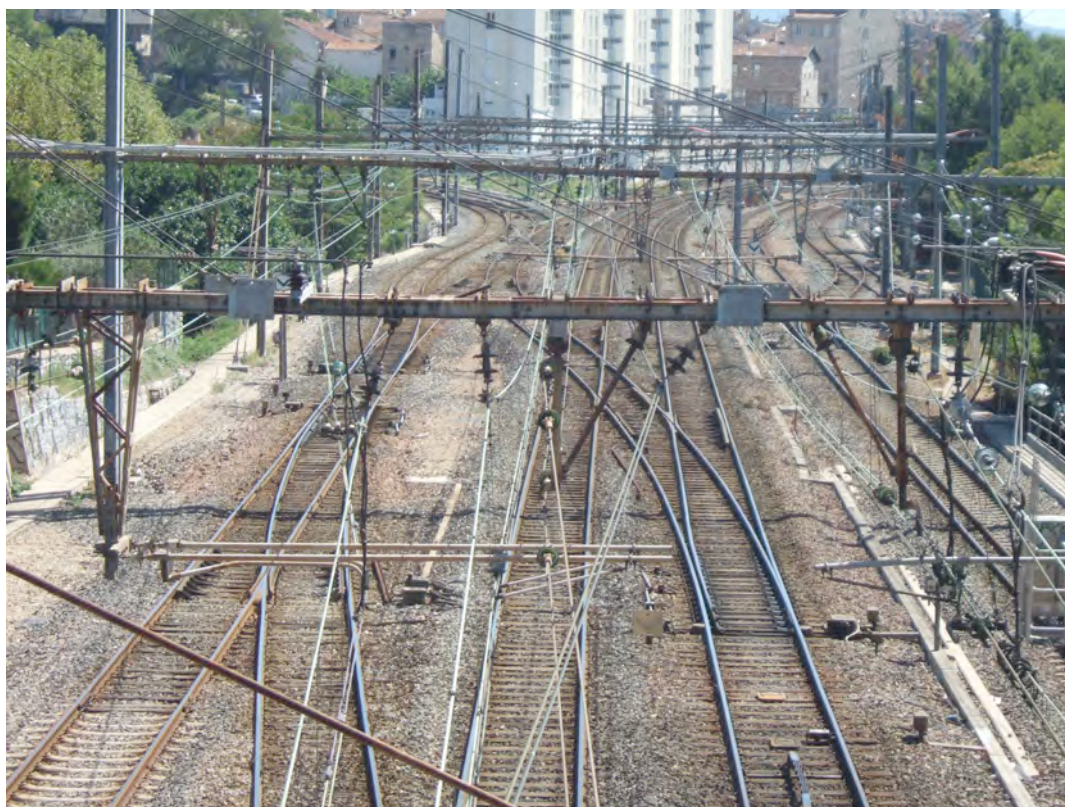
Vue vers le nord, toujours depuis le pont de l'impasse des Marronniers. Les voies d'Aix prennent rapidement de l'altitude. Les 3 voies PLM fusionnent en 2 voies. On aperçoit au loin sur la ligne d'Aix le tablier métallique bleu de l'Avenue Claude Monet.
